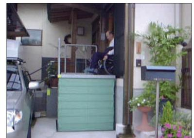
図10-2 事例1の段差解消機
